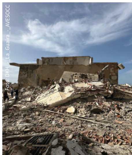
Das Bild zeigt die Zerstörung in der Region La Guaira nach dem Erdbeben in Venezuela
